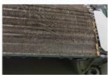
Krok 1 Špinavá vnitřní jednotka klimatizace
